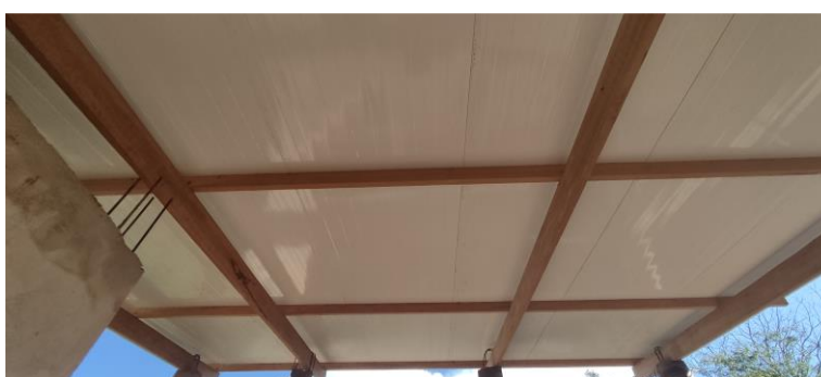
Chapa de aço na cor branca na face inferior
